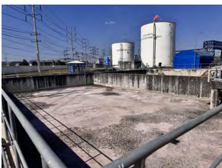
ภาพที่ 2-17 บ่อพักน้ำหล่อเย็น กรณีฉุกเฉิน
