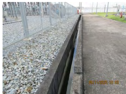
ภาพที่ 2-29 รางระบายน้ำฝนในพื้นที่โครงการ
