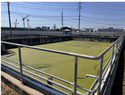
ภาพที่ 2-15 บ่อพักน้ำหล่อเย็น
