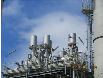
ภาพที่ 2-5 อุปกรณ์ช่วยในการลดเสียง (Silencer)
