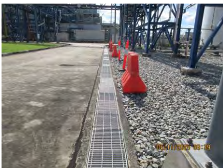
ภาพที่ 2-29 รางระบายน้ำฝนในพื้นที่โครงการ
